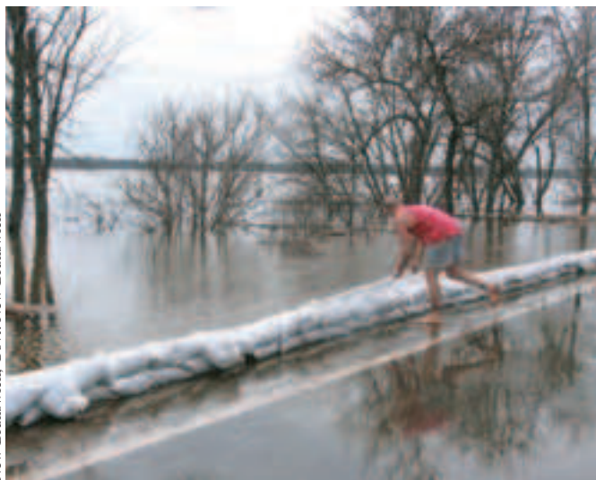
Digue avec des sacs de sable
