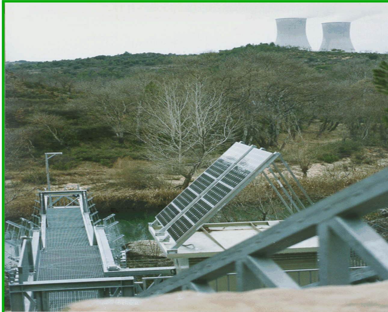
Estación de muestreo de agua superficial en continuo
