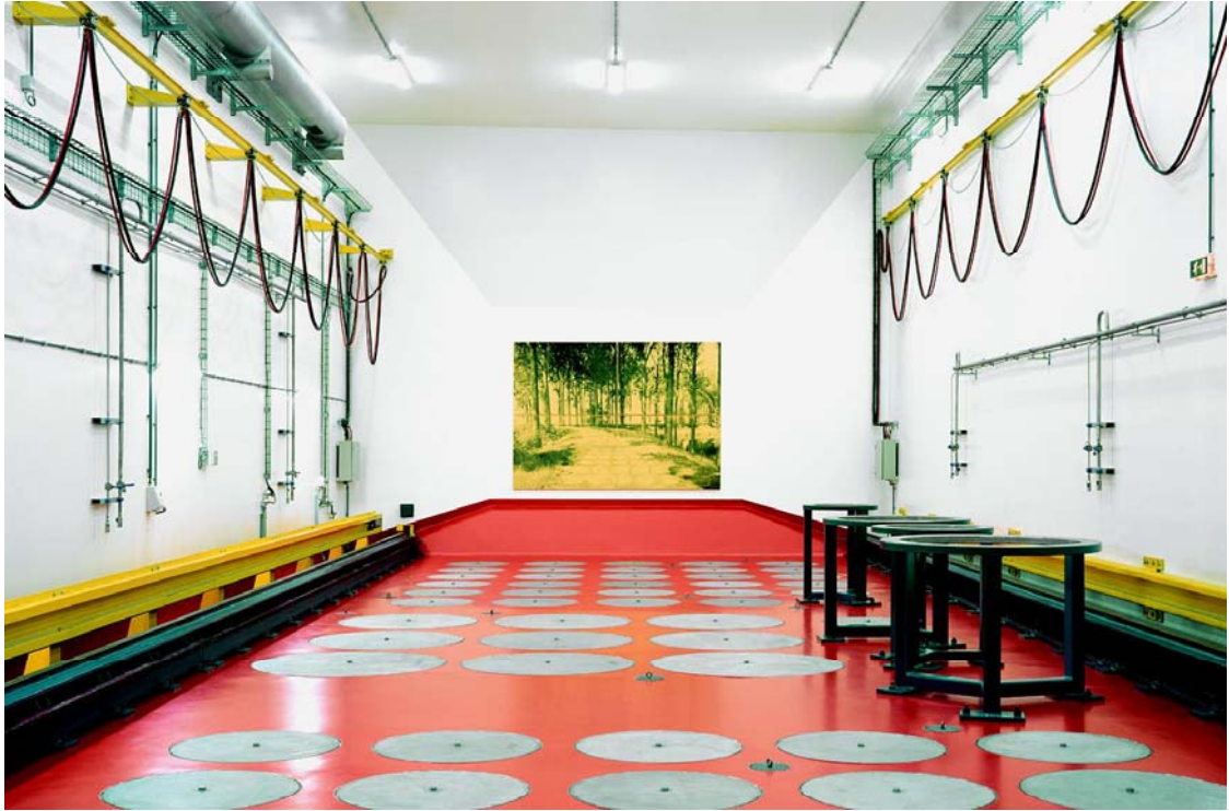
SALA SOBRE LA BÓVEDA DE ALMACENAMIENTO DE LAS CÁPSULAS CON RESIDUOS EMISORES DE CALOR
