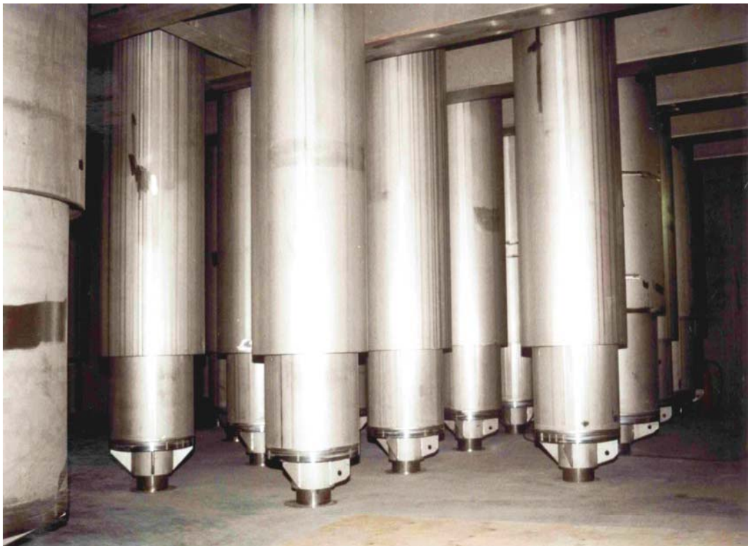
BÓVEDA DE ALMACENAMIENTO PARA RESIDUOS EMISORES DE CALOR
