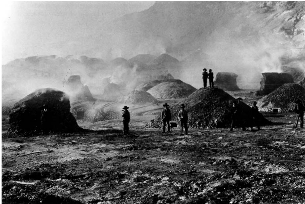
Minas de Riotinto. Vista del campo de teleras encendidas. Ca. 1888.
